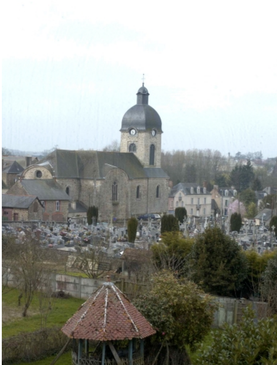
Vue de situation nord est
