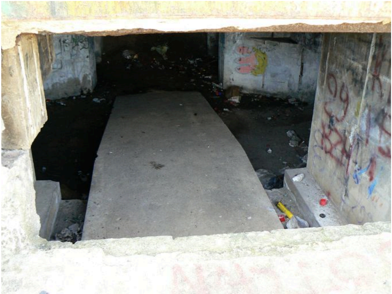
Intérieur de la casemate
