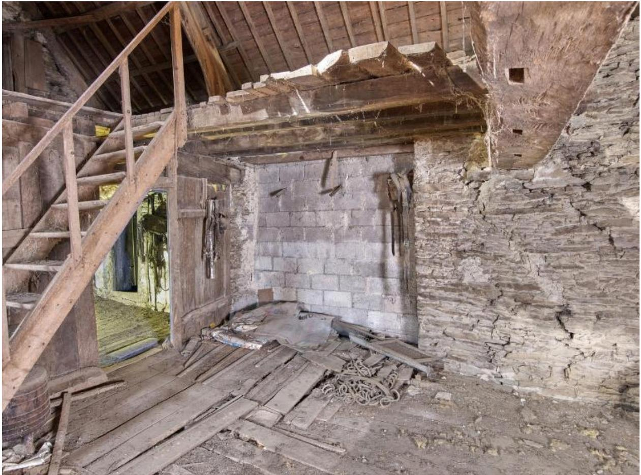
Logis. Etage. Emplacement de l'escalier en vis en demi hors-oeuvre ; à droite poutre avec les mortaises d'une cloison disparue ; à gauche cloison en bois tardive
