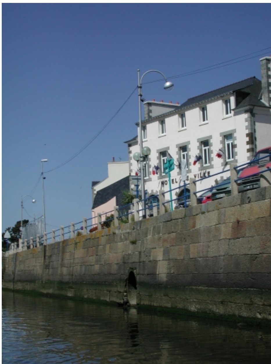
Appareillage des pierres du mur du quai Jean Bart
