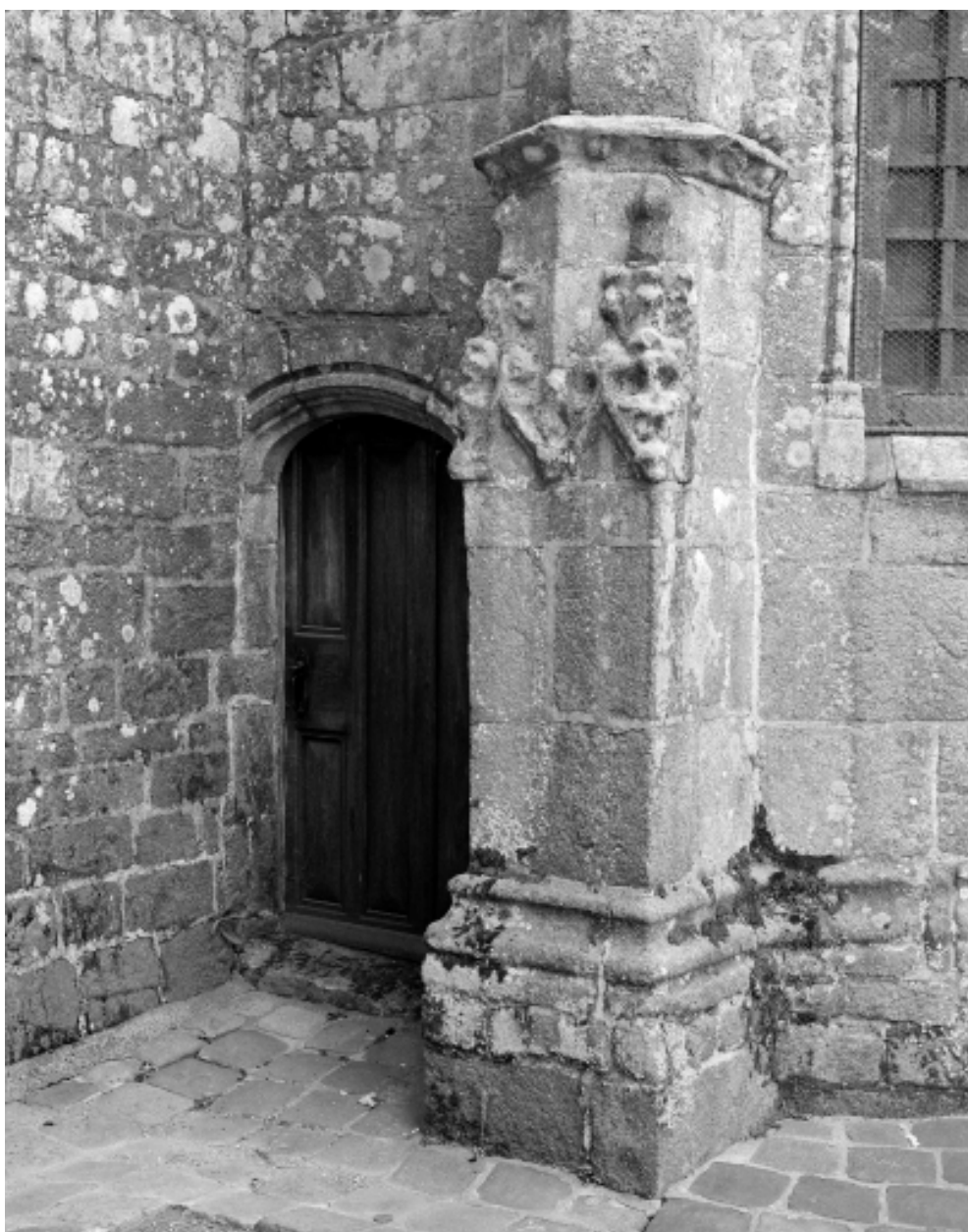
Elévation sud, chapelle saint-Yves : porte et contrefort.
