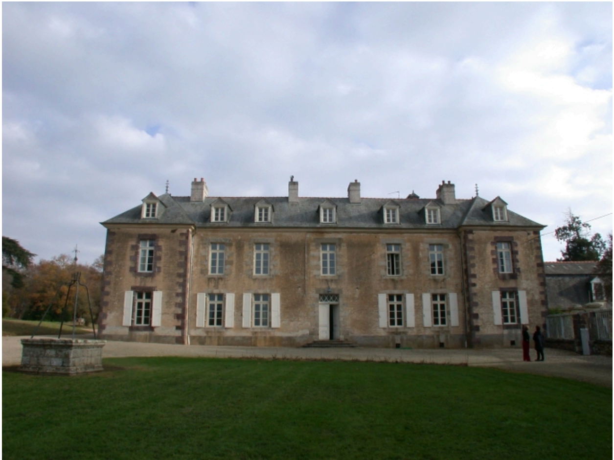
Vue générale du château, façade antérieure
