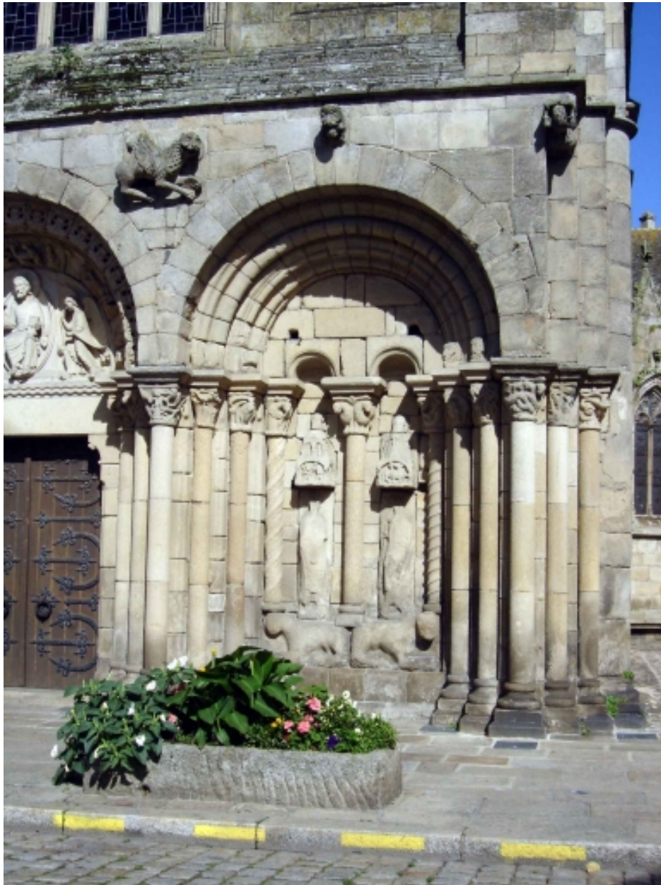
Façade occidentale : arcade sud
