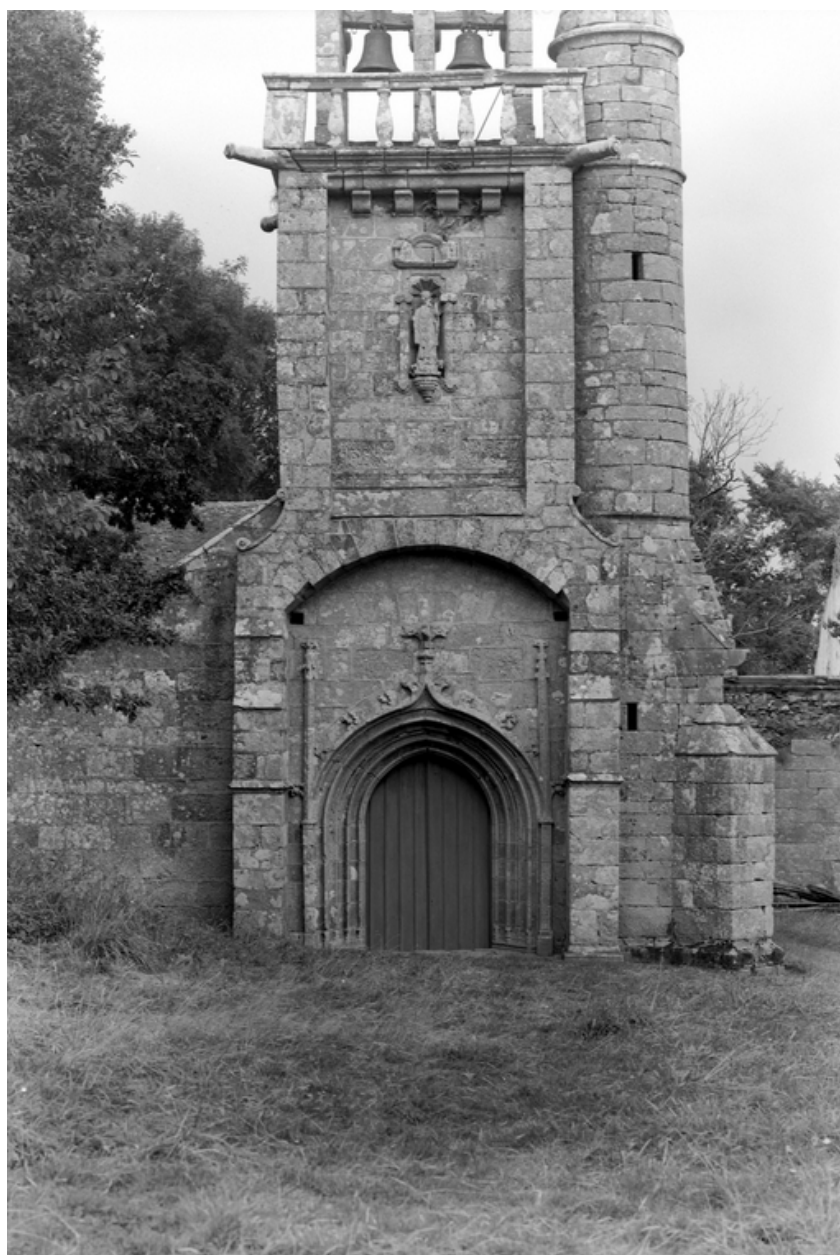
Face ouest : vue de la partie inférieure
