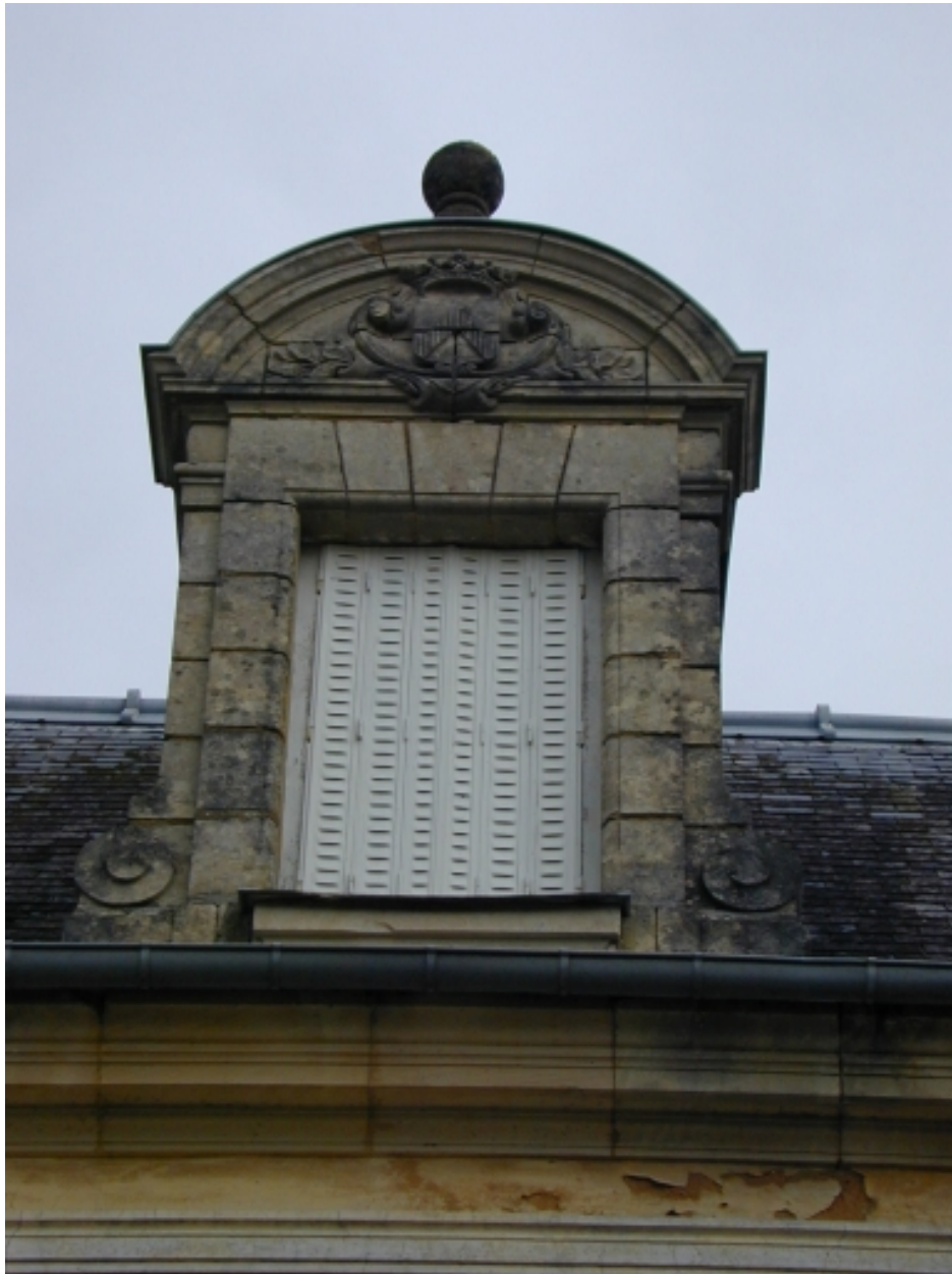
Corps principal, lucarne du pavillon avec un fronton aux armes des Lambert : détail
