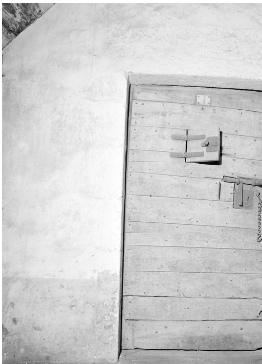
Cellule du comble, vantail de porte.
