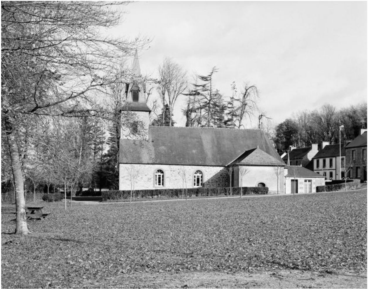
Chapelle : élévation sud
