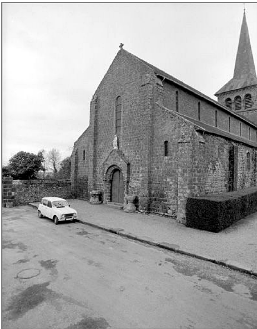
Elévation Ouest : vue générale
