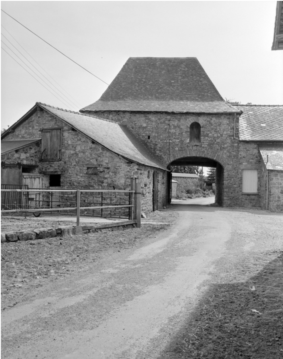
Vue générale du porche, côté chemin.
