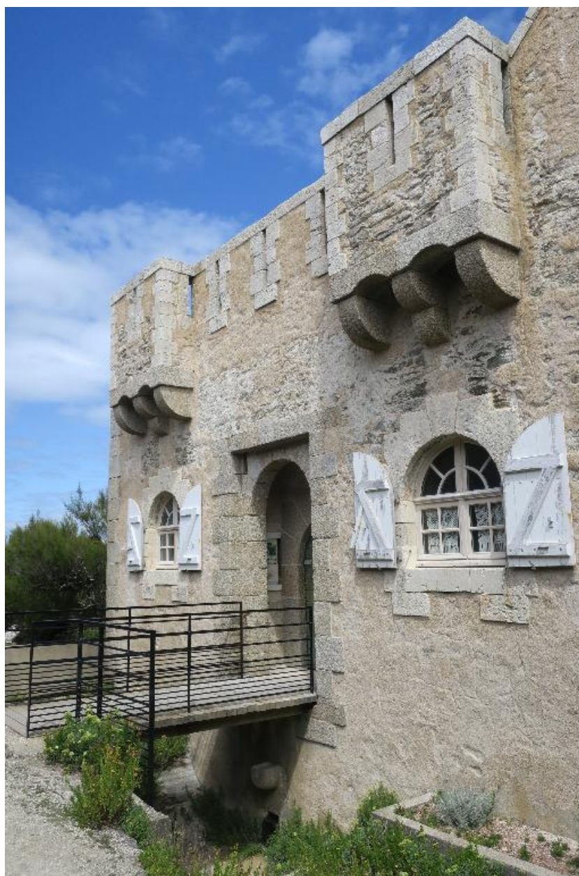
Sauzon, pointe des Poulains, corps de garde crénelé dit Fort Sarah Bernhardt, face ouest.
