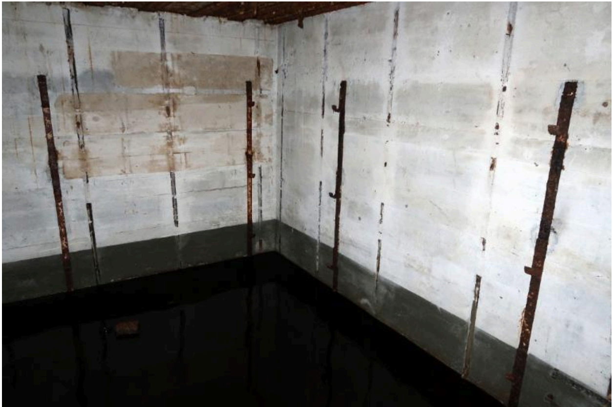
Vue intérieure : salle de garde nord, détail des murs nord et ouest avec les supports muraux pour six couchettes tubulaires
