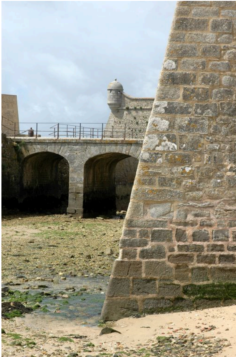
Vue de la citadelle de Port-Louis : pont-dormant de la demi-lune. En arrière-plan : l'échauguette du bastion de Groix
