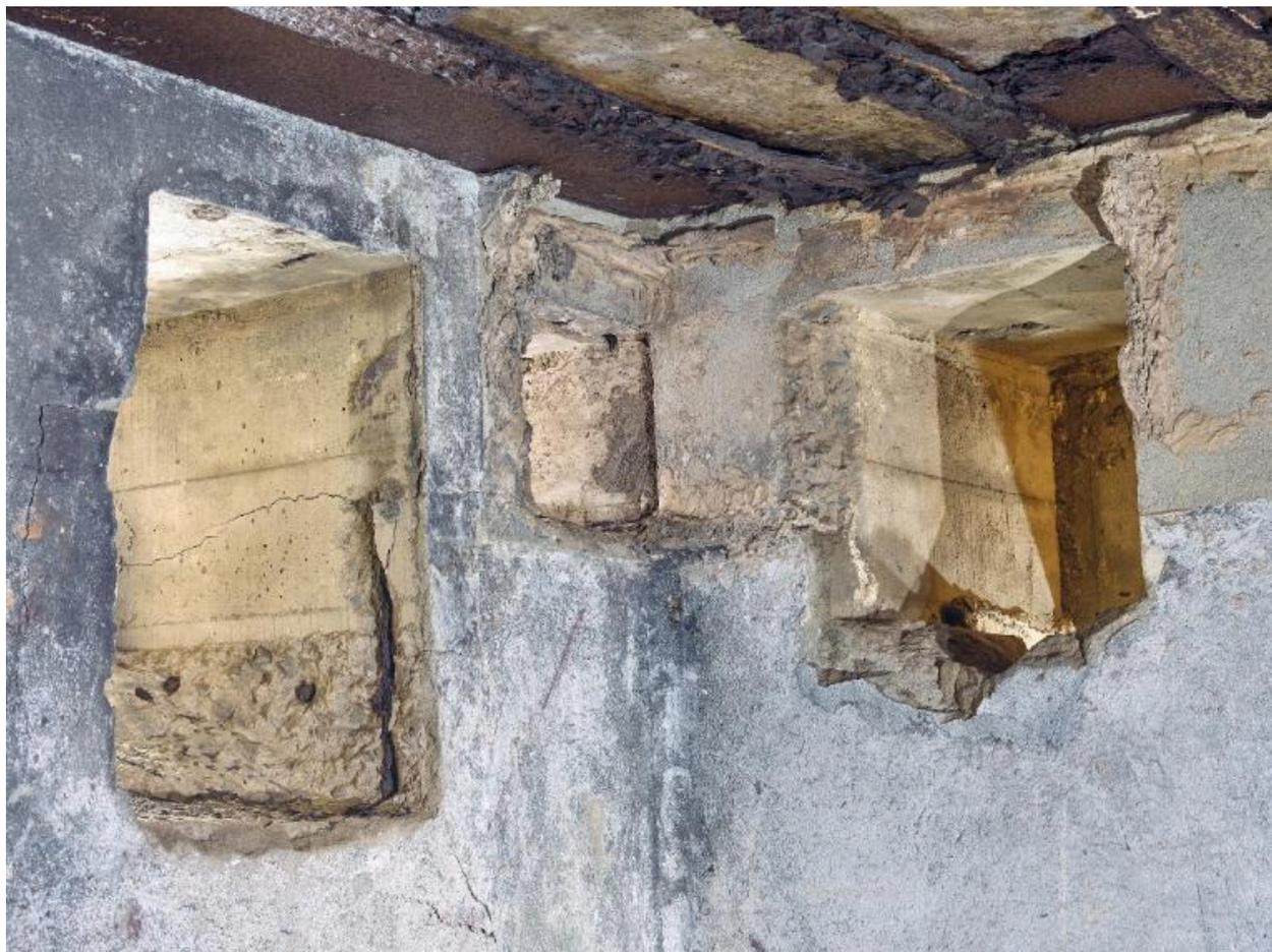
Vue de la salle des ventilateurs, prises d'air. Les tuyaux n'ont pas été posés : ils ont été remplacés par des conduites (en brique ?) montées au plâtre
