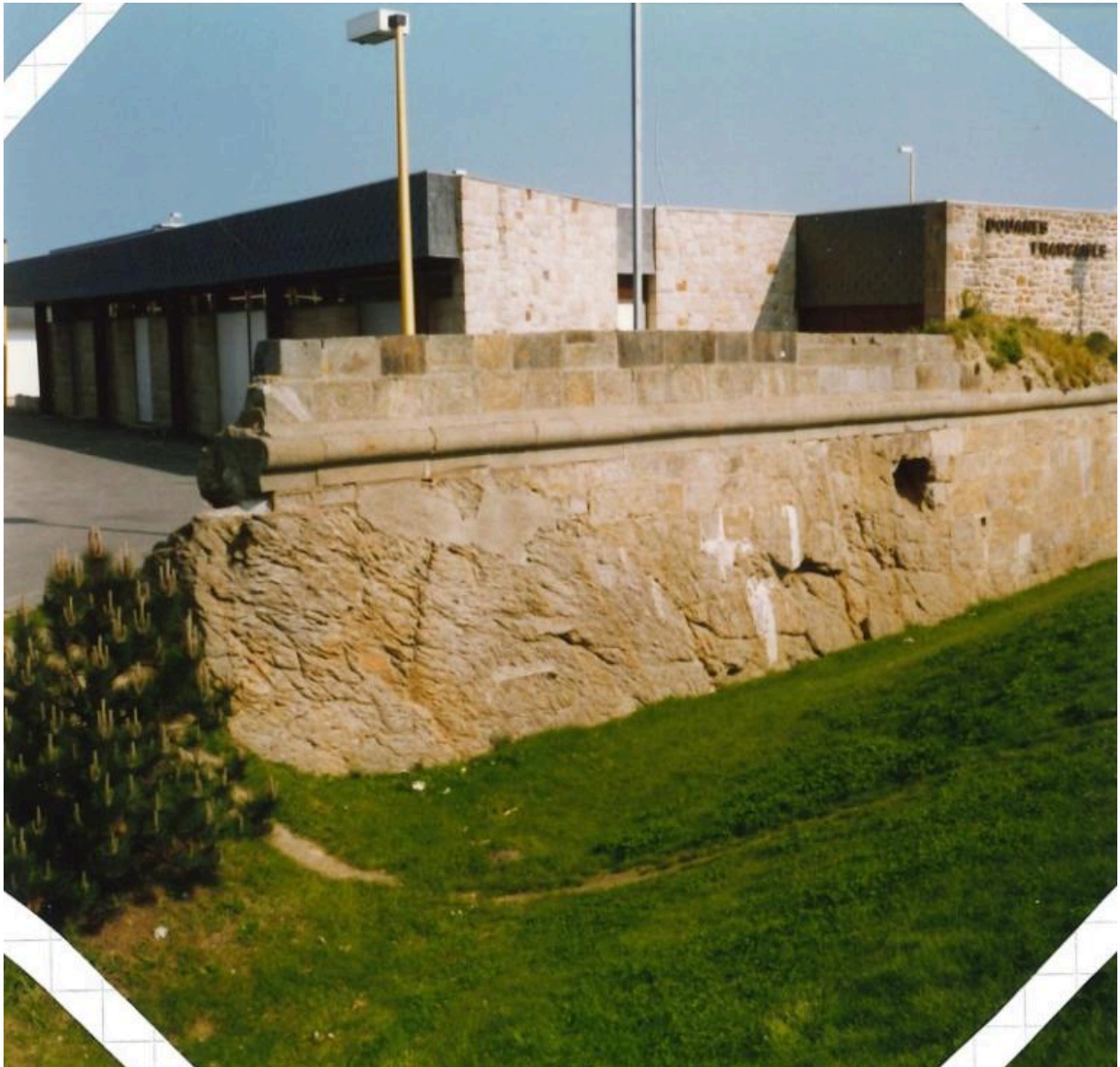
Vue générale depuis l'est : escarpe sud-est, mai 1991
