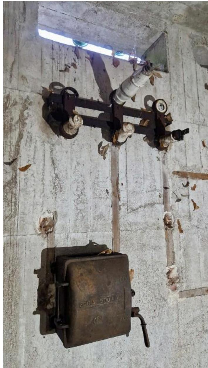
Vue intérieure : arrivée des câbles du réseau électrique. Les câbles alimentaient en électricité la batterie antiaérienne via un transformateur. Le boîtier a été ajouté plus tard
