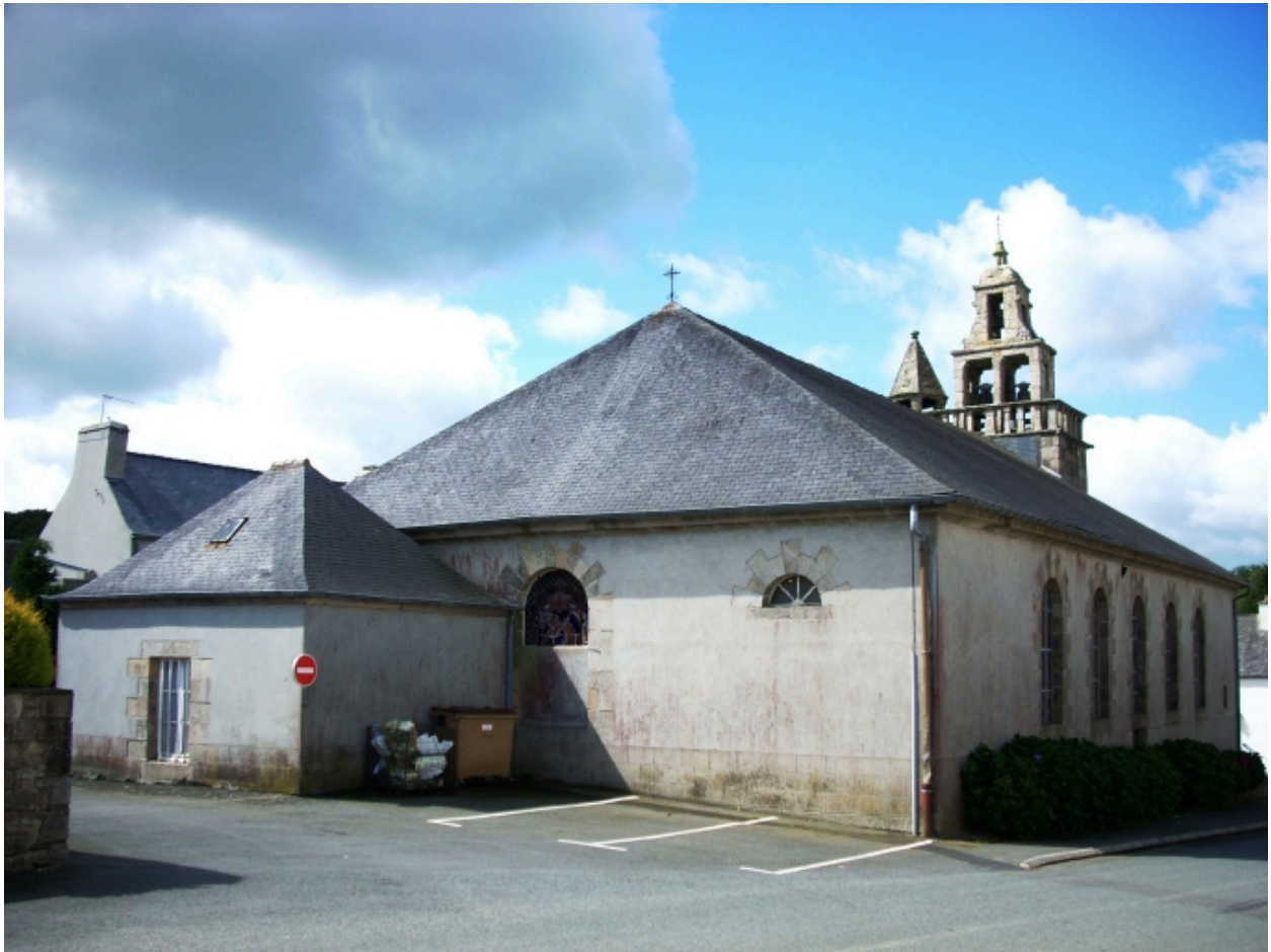
Lanneanou, église paroissiale Saint-Jean-Baptiste : vue générale sud-est
