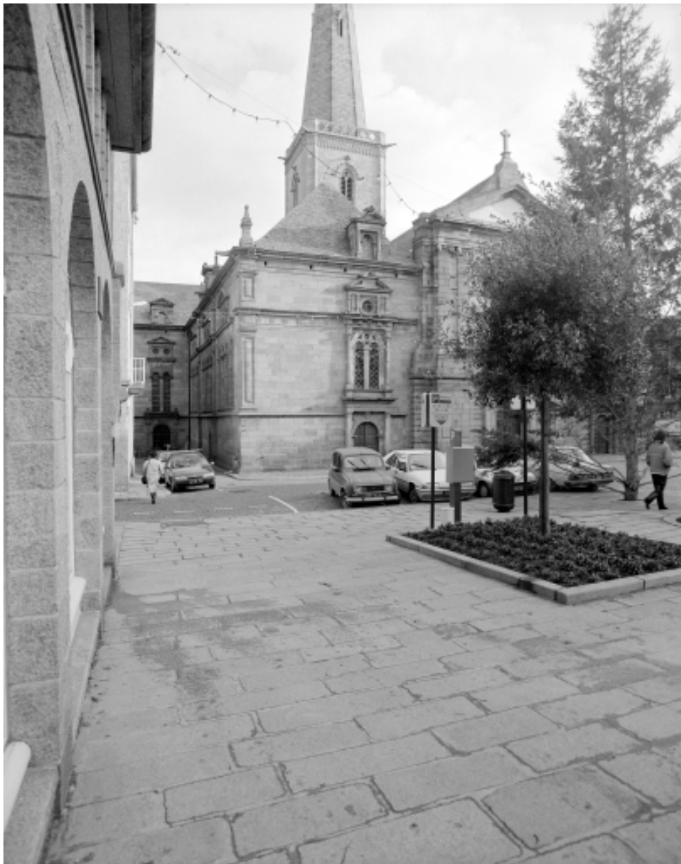
Elévation Nord-Ouest : vue générale
