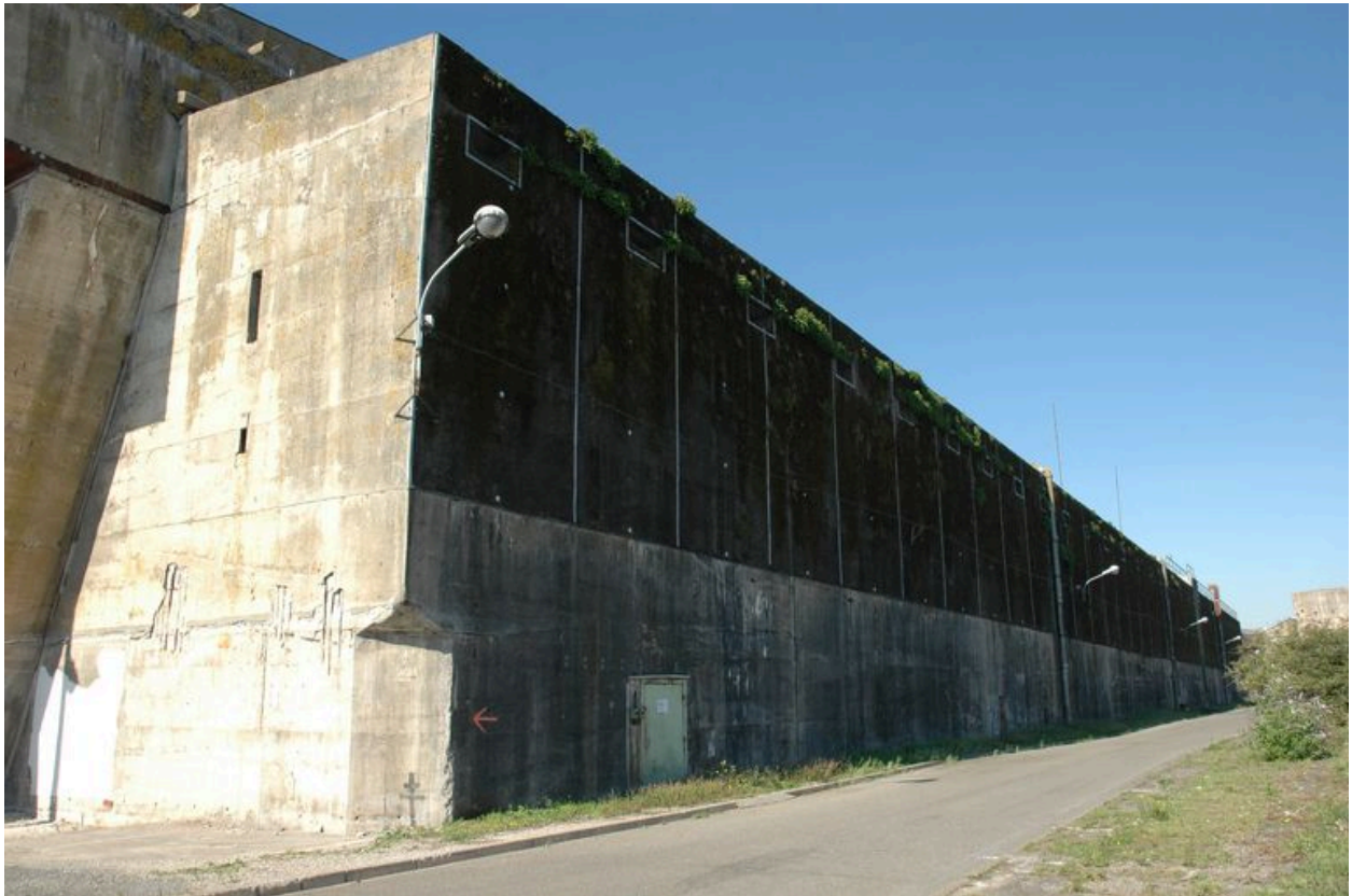
Vue de l'extension nord-est (état en 2005)
