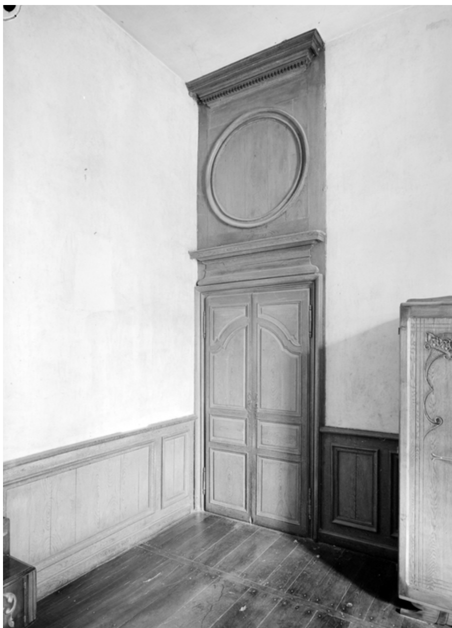
Aile est, pièce 1, porte de l'angle nord-est, état en 1967
