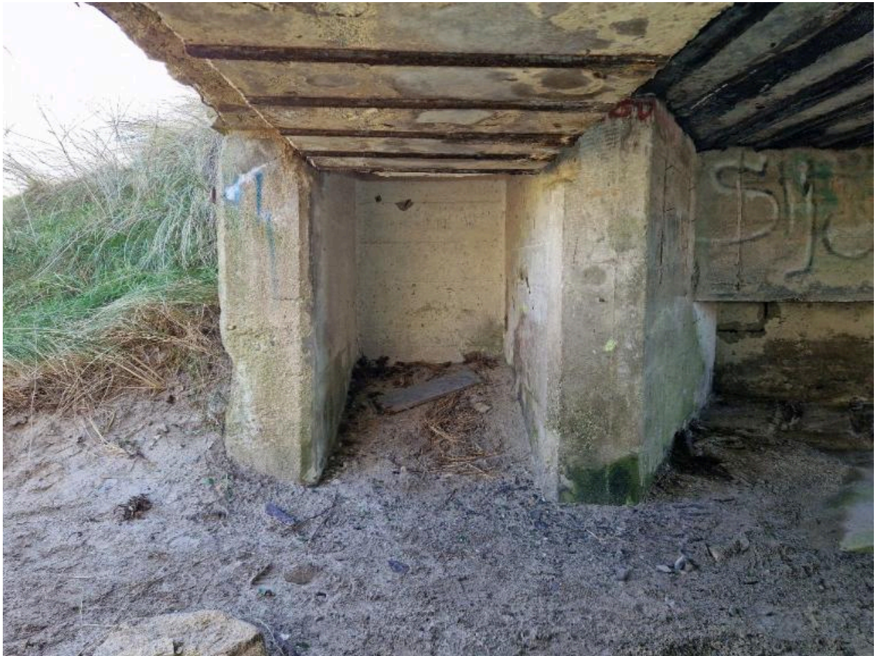
Vue intérieure : niche à munitions (à gauche de l'entrée)
