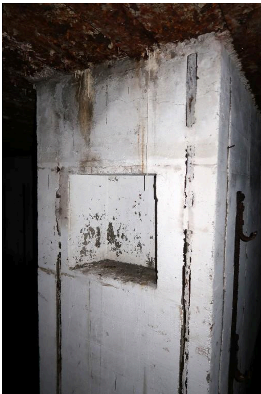
Vue intérieure : mur de refend avec niche murale
