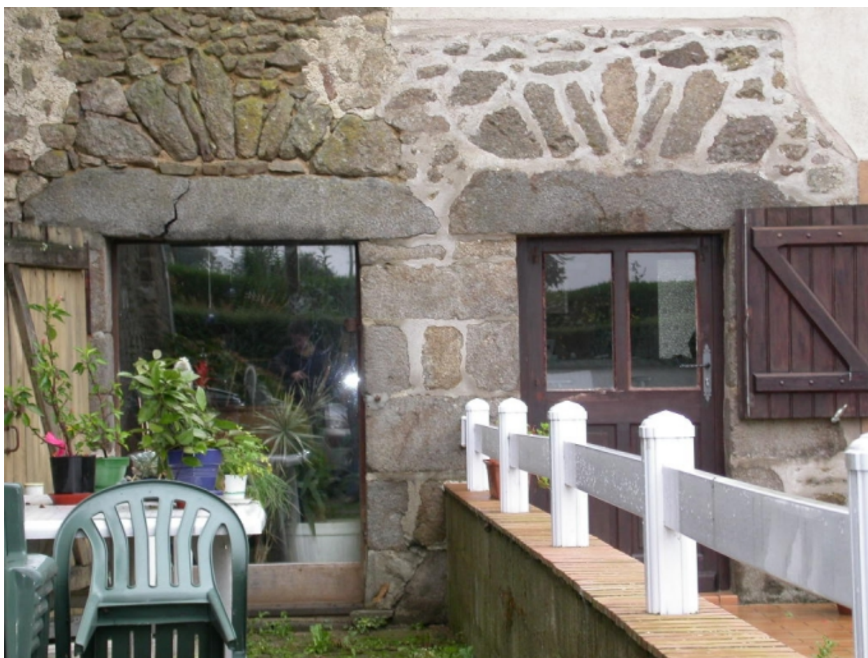
Détail des portes jumelées
