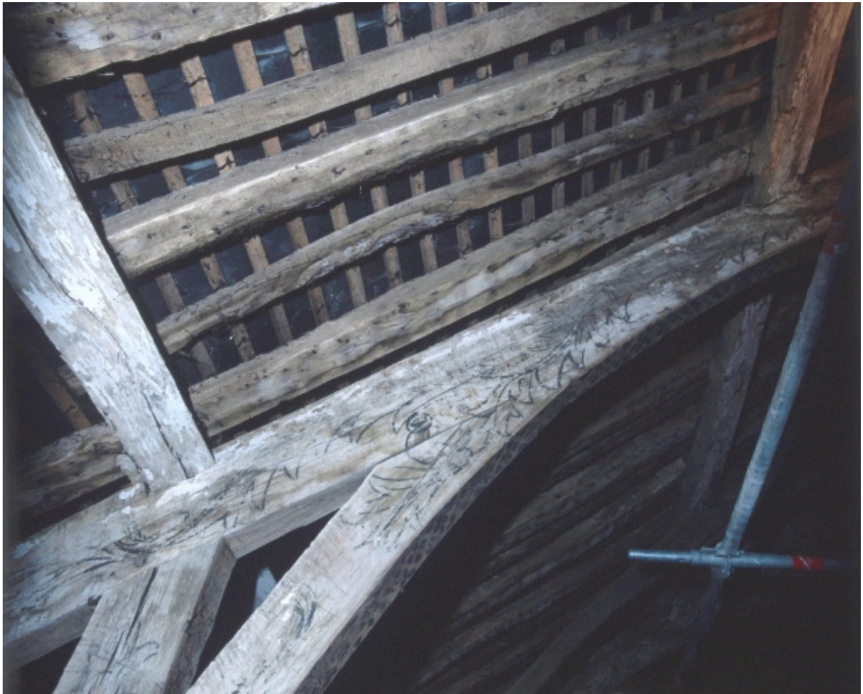
Détail sous charpente.
