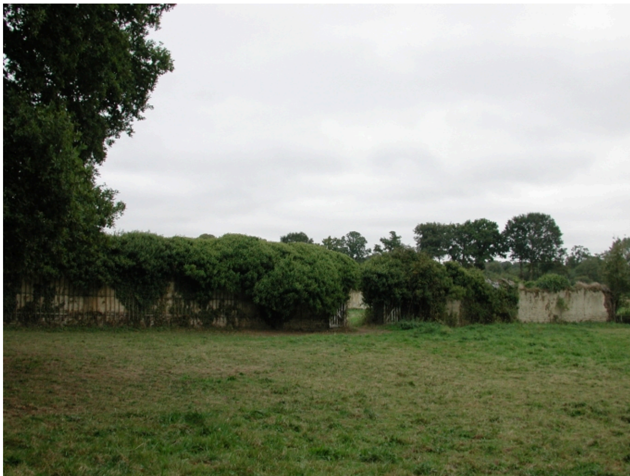
Mur de clôture de l'ancien jardin potager
