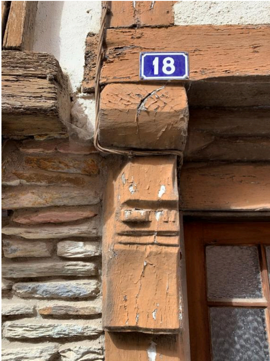
Maison à droite. Détail de console
