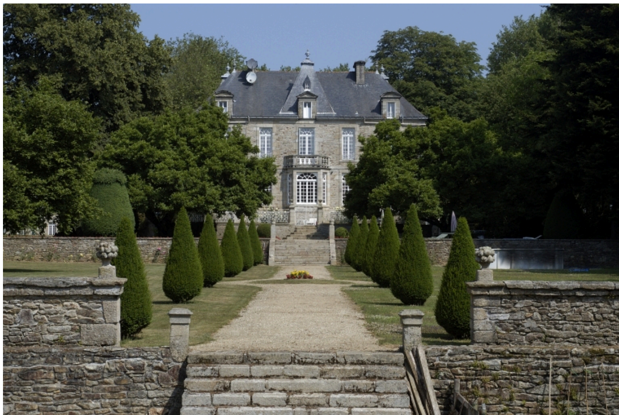
Vue générale sud depuis le jardin
