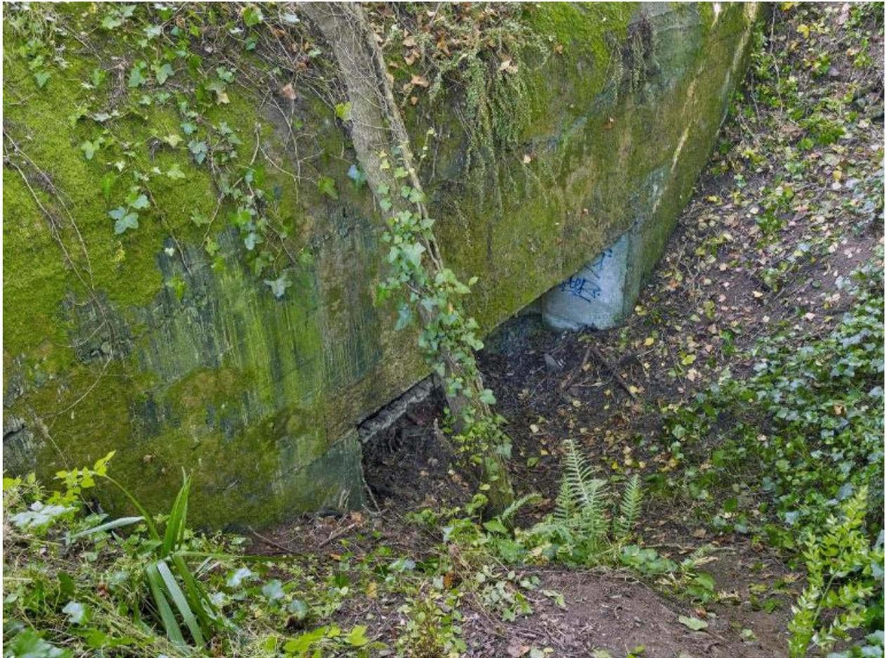
Vue du bunker - casemate de type 680 pour un canon de 7,5 cm ou 7,62 cm situé au Sud : emplacement de l'entrée (photographiée de l'extérieur). Son entrée est partiellement murée par des parpaings et remblayée. Enterré dans le sol, le bunker est masqué par la végétation
