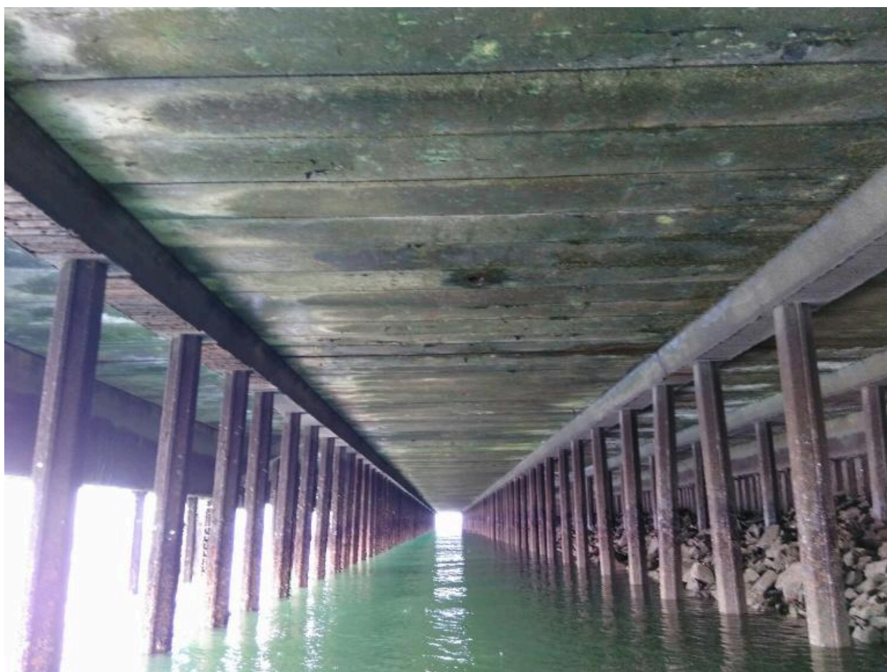
Quai de réparation n°1, poutres et palpieux métalliques
