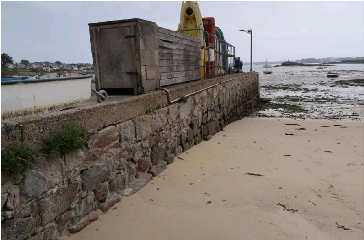
Cale de Porz Kernog, couronnement béton sur ancienne cale maçonnée
