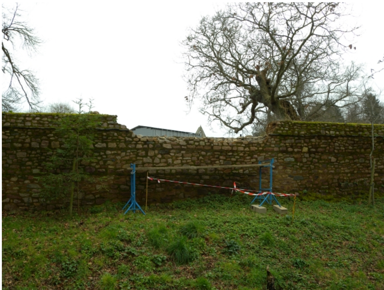
Vue du mur d'enceinte en cours de restauration
