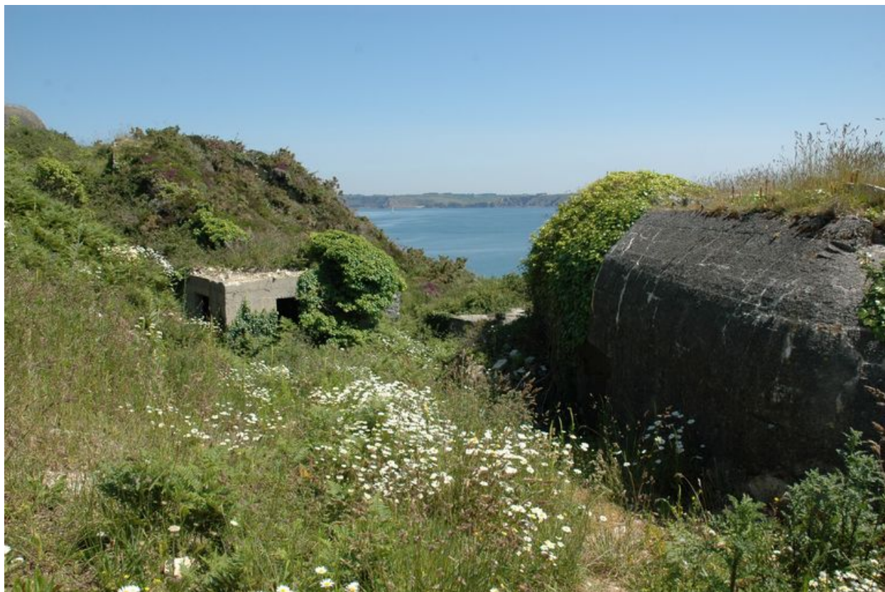
Vue du bunker - casemate sud type 671 sud et deux abris en béton armé (état en 2005). Le site est envahi par la végétation
