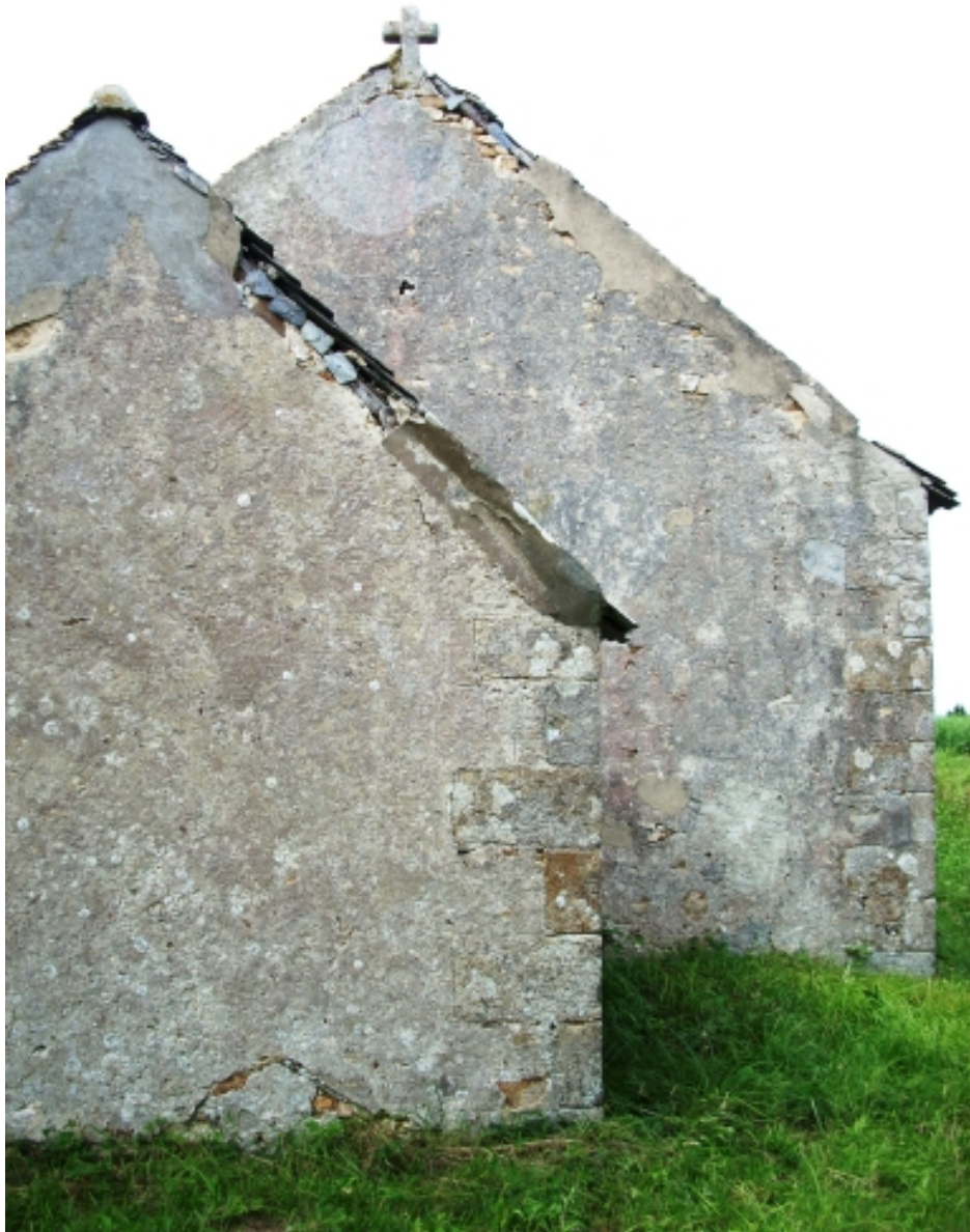
Plourin-lès-Morlaix, chapelle Saint-Michel : élévation est
