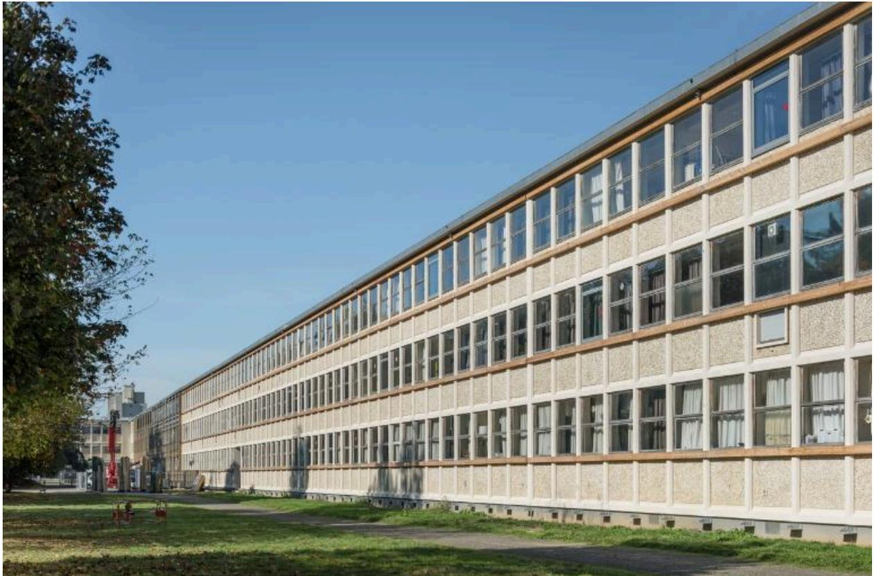
Façade sud du bâtiment C (externat) : la plus longue barre scolaire de Bretagne (200m). Les bandeaux de fenêtres renforcent l'impression de longueur, et atténuent la verticalité inhérente à la répétition de la trame de 1,75m. De lourds travaux de réhabilitation thermique débutent (à l'arrière plan) : sous les bandeaux de fenêtres, des madriers de bois ont été posés pour fixer les panneaux préfabriqués (bac alu et isolant).
