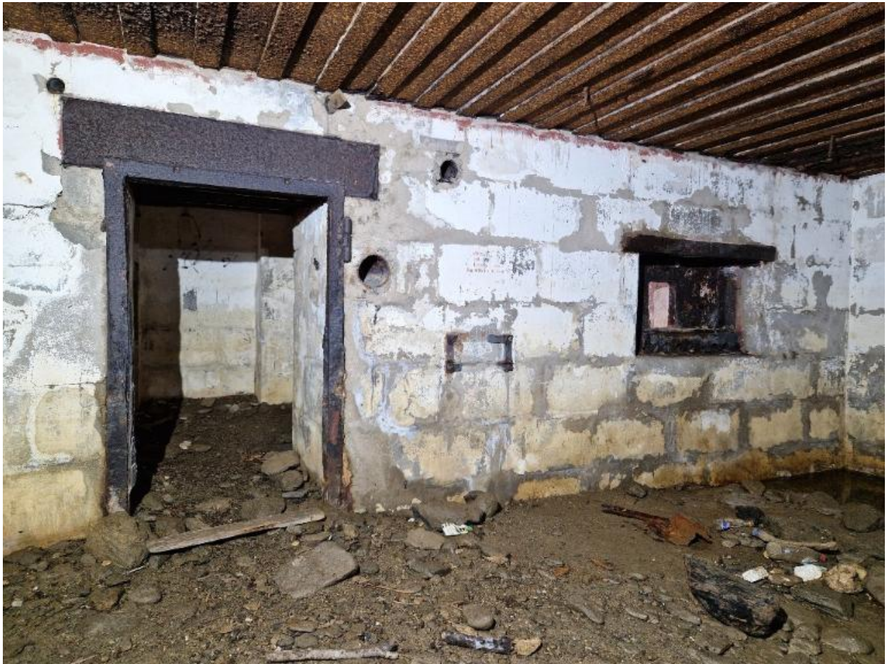
Vue intérieure : salle de garde est. La porte donne sur les accès nord (est et ouest)
