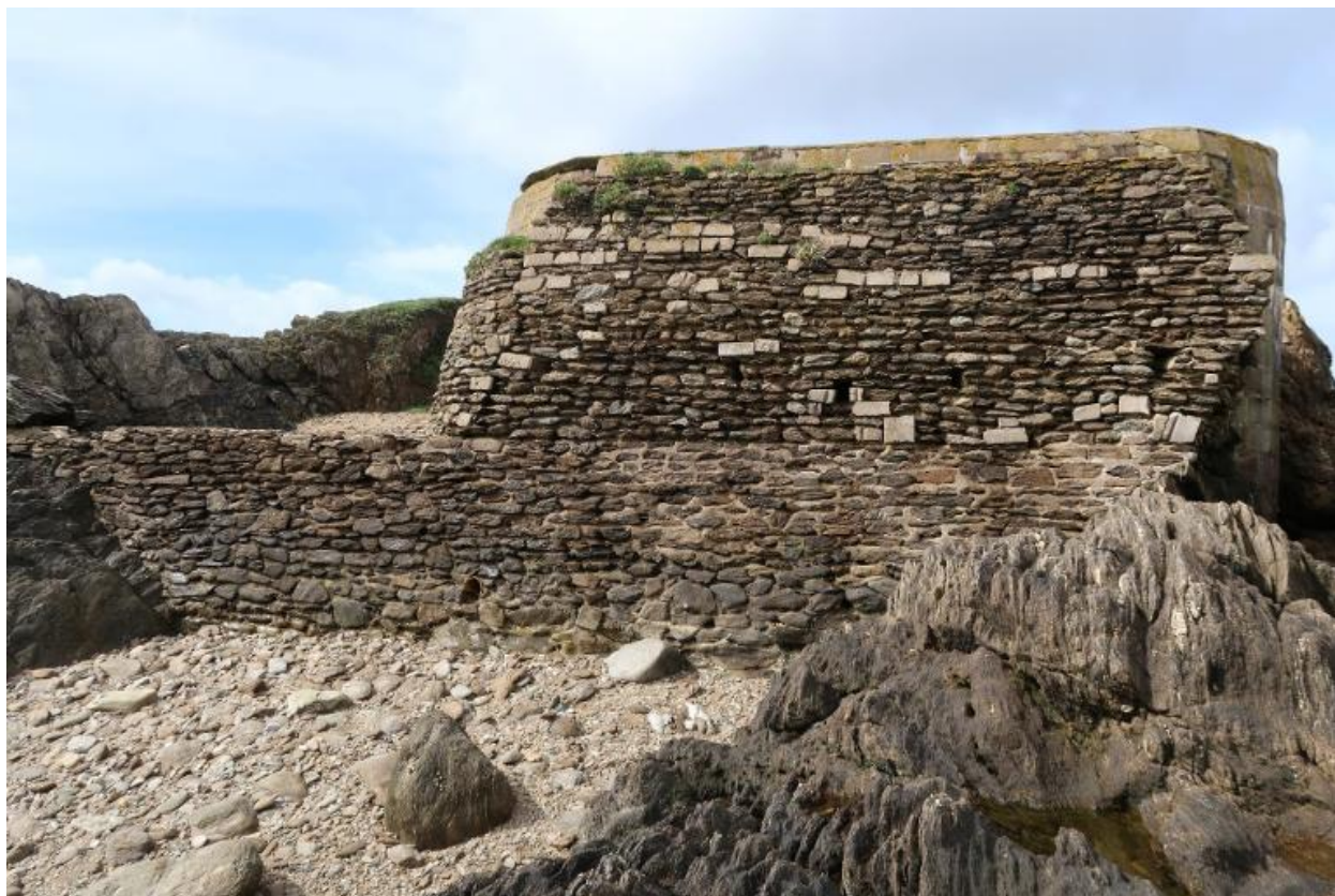
Vue générale depuis l'est. La maçonnerie de moellon masque le bunker - abri
