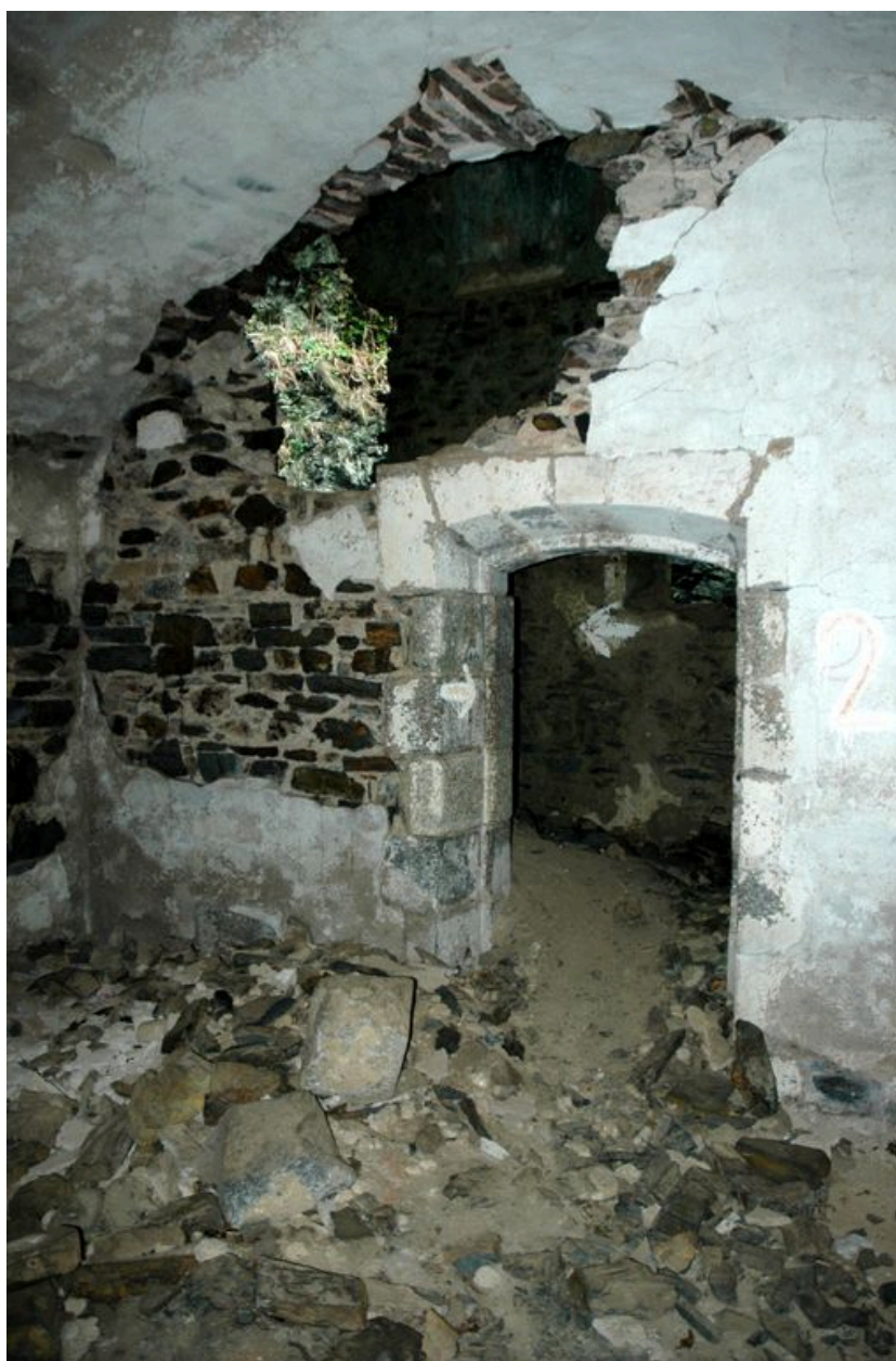
Vue de la caserne défensive Robert : troisième salle voûtée, magasin à poudre
