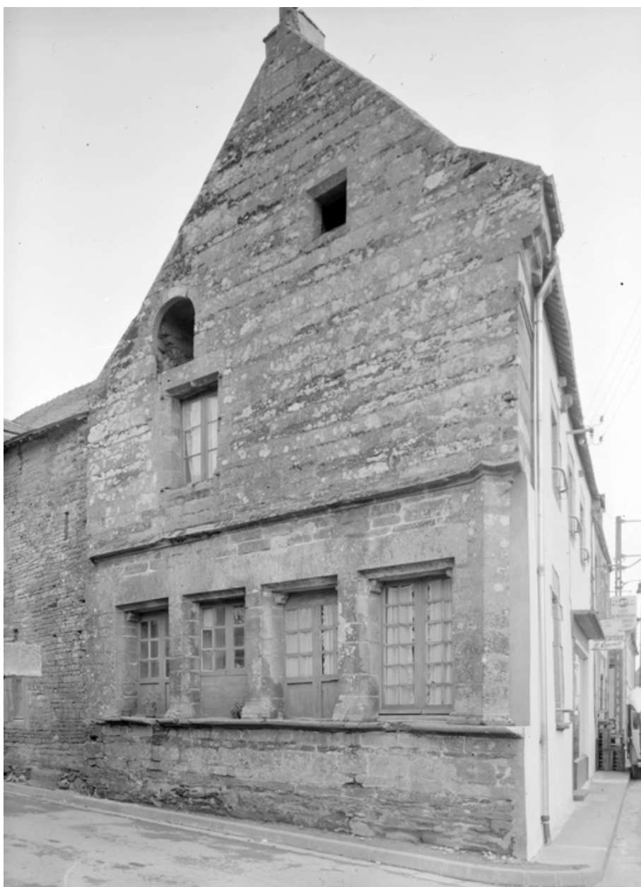
Maison B, vue d'ensemble du pignon nord.
