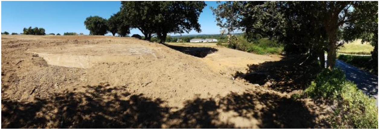
Vue de situation depuis l'est (août 2022, chantier en cours)
