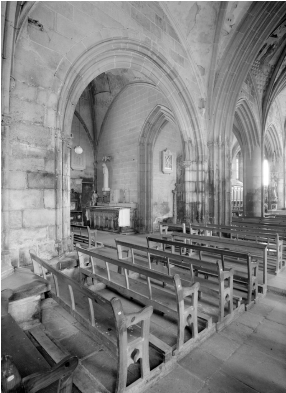
Nef angle sud-ouest, vue transversale.
