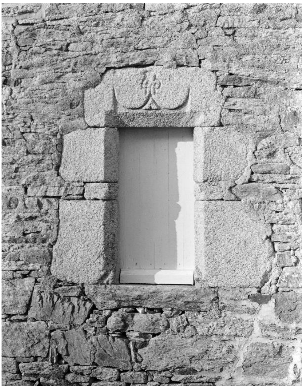
Fenêtre du premier étage, détail du linteau.
