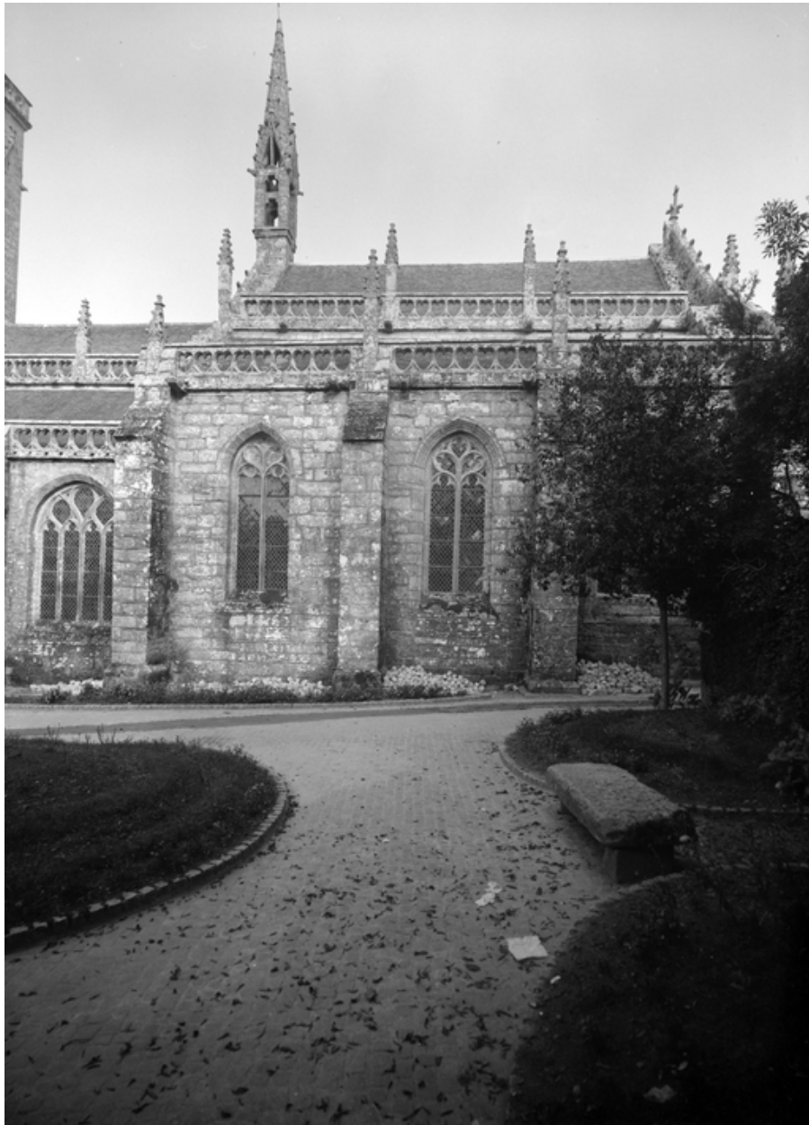
Façade sud, vue générale
