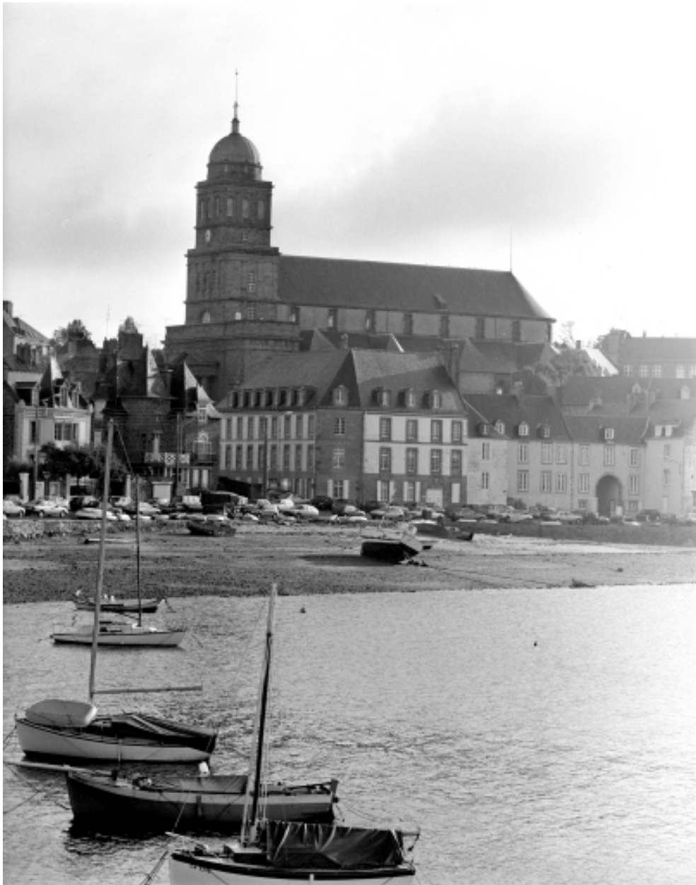
Elévation Ouest : vue générale
