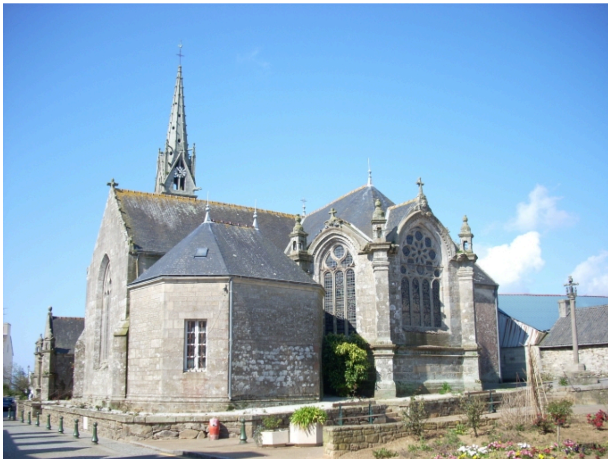
Plomodiern, église paroissiale Saint-Mahouarn : vue générale sud-est
