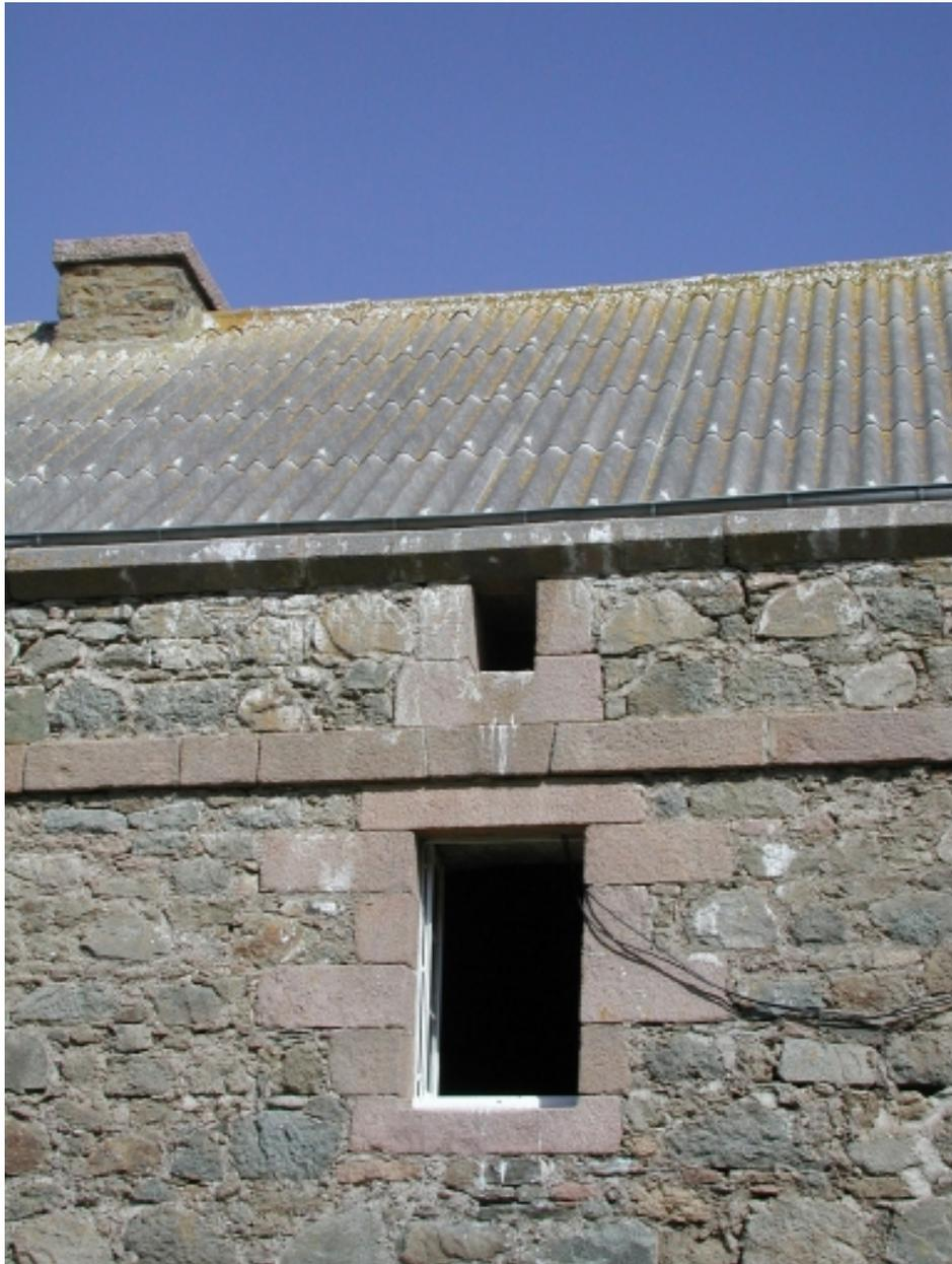
Vue de détail de la façade sud de la caserne : remarquer le bandeau de granite sous l'étage de combles à surcroît et la gouttière
