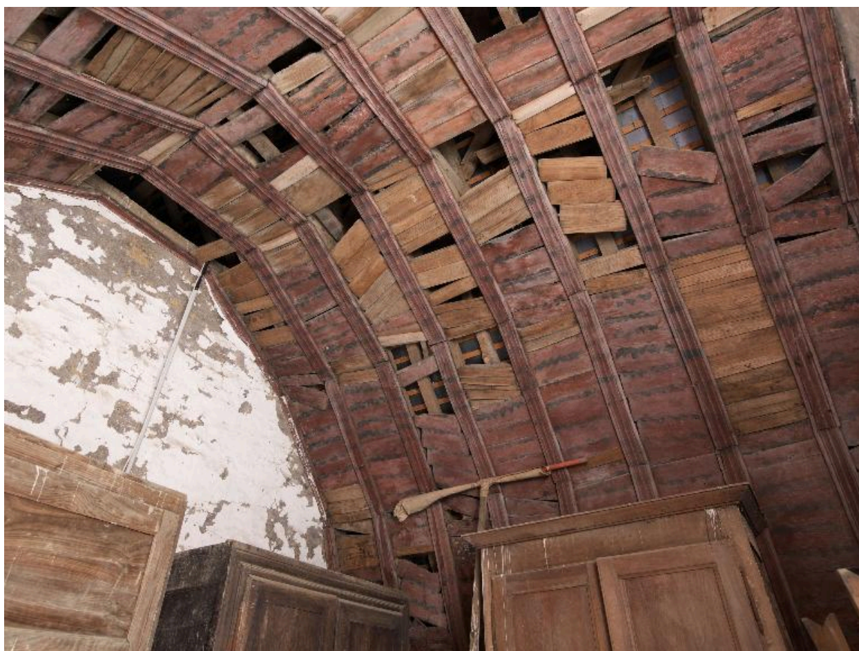
Charpente de la sacristie Sud
