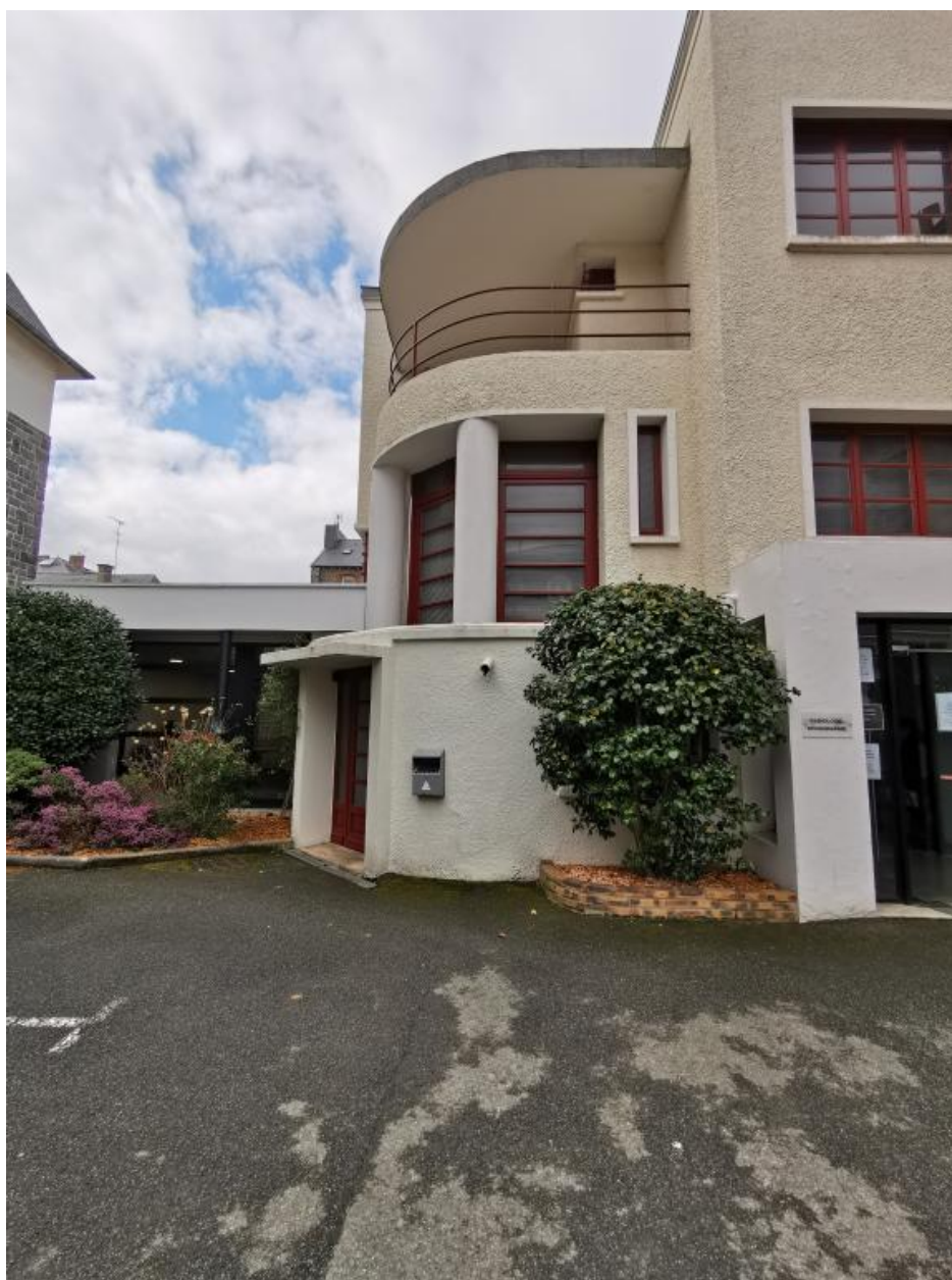
Vue de l'ancienne entrée d'angle transformée
